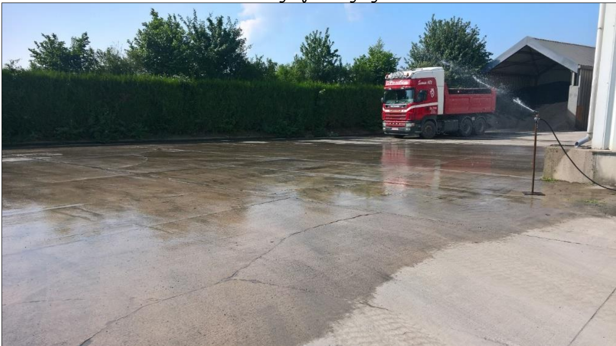
Foto 4 Betonverharding bij de uitgang van de laadzone
