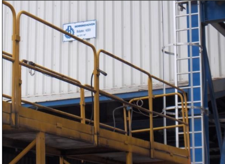
Foto 7 Loopbrug die toegang biedt tot de laadbak van de vrachtwagens
